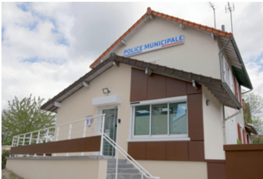
Extérieur des nouveaux locaux de la police municipale, 1 rue d'Armentières
